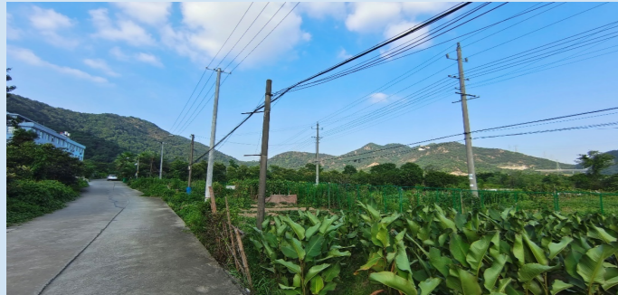
红线内电力和通信设施
