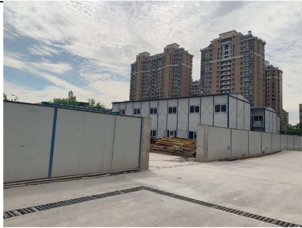
拟建 110kV 爱国变电站站址现状
