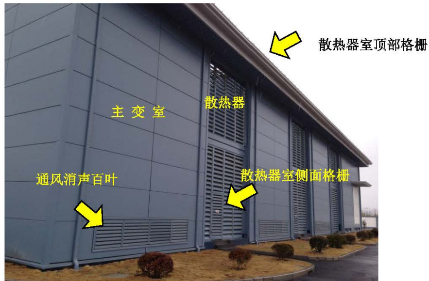
图 1 同类工程的主变及散热器布置方式
