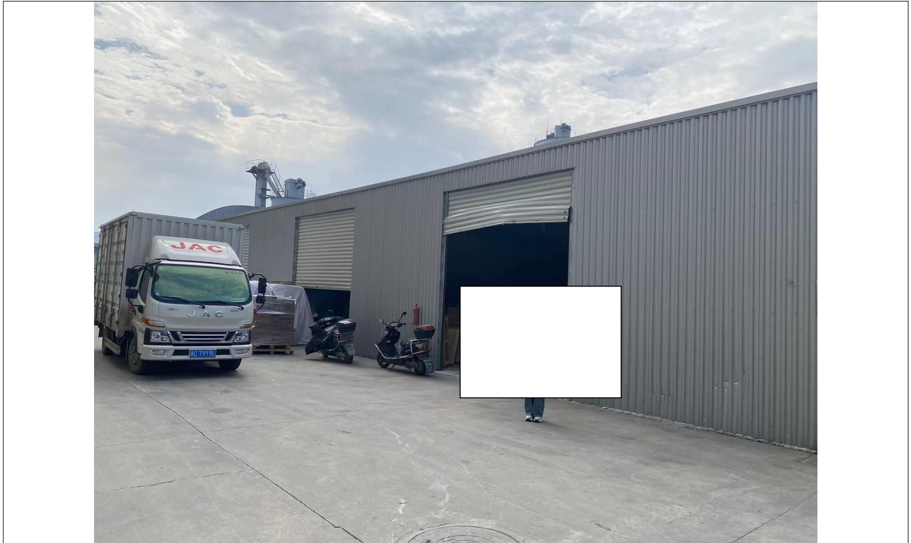
附图1 编制主持人现场勘察照片
